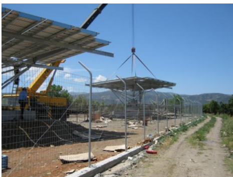
Εικόνα 35: Τοποθέτηση με γερανό του Κινητού Πλαισίου με τα εγκατεστημένα ΦΒ Πλάισια πάνω στη Βάση
