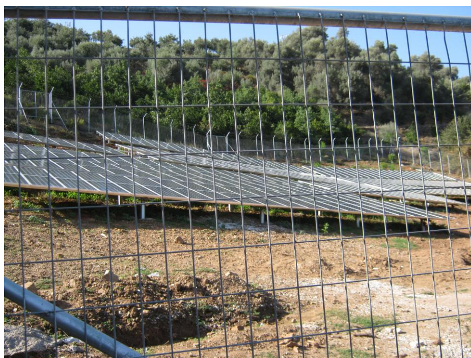
Εικόνα 66: ΦΒ Πάρκο με βάση σταθερής γωνίας κλίσης σε κεκλιμένο έδαφος
