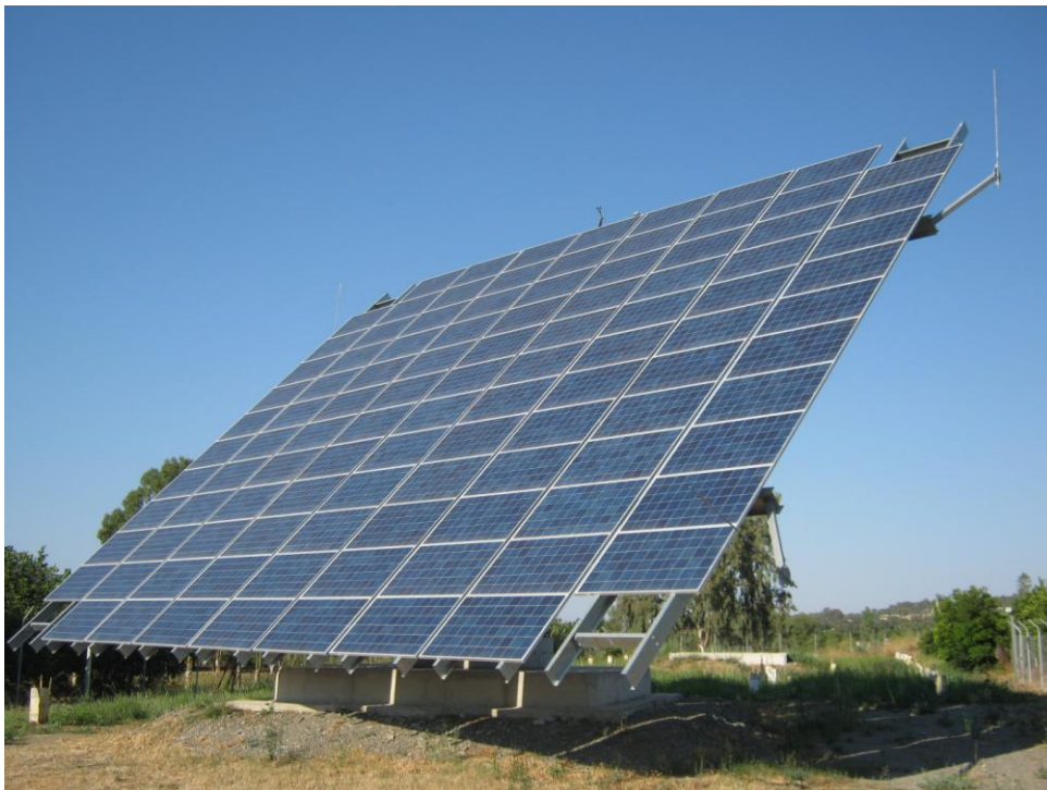
Εικόνα 68: Πολυκρυσταλλικά Πλαίσια σε tracker
