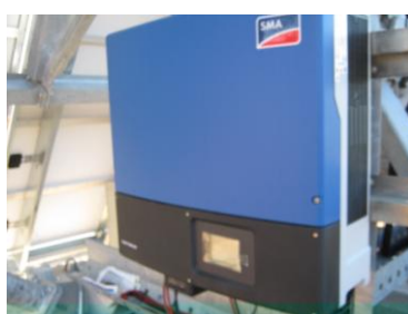
Εικόνα 23: Sunny Tripower 17000TL
