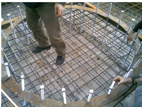
Εικόνα 32: Τοποθέτηση Αγκυρίων
