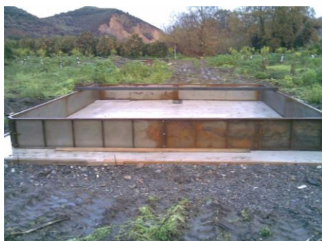
Εικόνα 29: Πλήρωση της εκσκαφής με αμμοχάλικο και τοποθέτηση μιας στρώσης σκυροδέματος πάχους 5-10 cm
