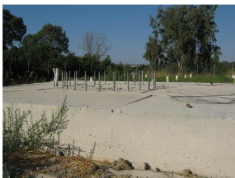
Εικόνα 33: Πλήρωση με σκυρόδεμα και αφαίρεση καλουπιού.
