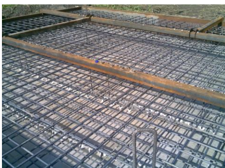
Εικόνα 30: Τοποθέτηση καλουπιού και εσωτερικού σύρματος
