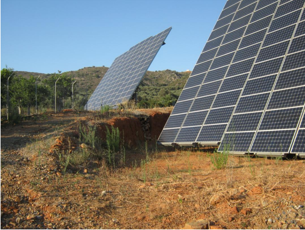
Εικόνα 69: Εγκατάσταση ΦΒ Πάρκου με Μόνο-Κρυσταλλικά πλαίσια, σε κεκλιμένο επίπεδο.
