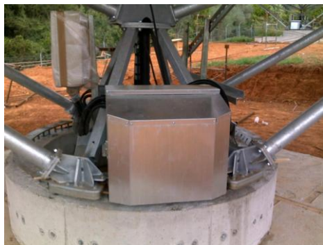
Εικόνα 34: Τοποθέτηση βάσης (tracker) πάνω στα αγκύρια
