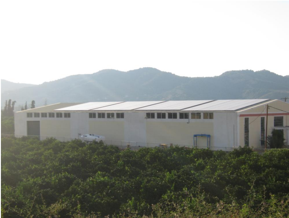
Εικόνα 67: ΦΒ Πάρκο σε στέγη με μικρή κλίση
