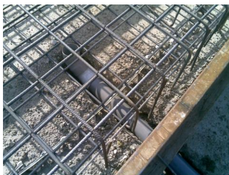
Εικόνα 31: Τοποθέτηση σωλήνα Όδευσης Καλωδίων
